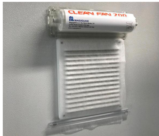
CLEAN FAN installato su ventola di un armadio elettrico
